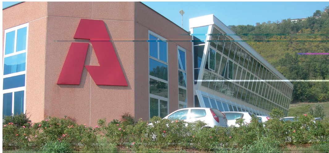
La sede di Allied International Group a Nibbiano Val Tidone in località Vascellino
